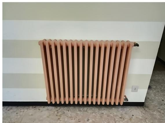
Figura 4.7 - Particolare dei radiatori installati sulle pareti degli ambienti interni
